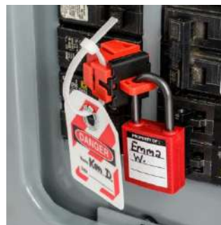
Ejemplo Sistema Bloqueo Interruptores
